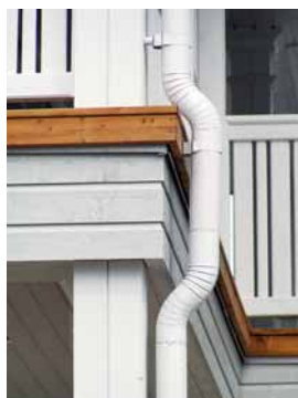
Хомут для крепления водосточной трубы
